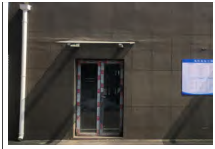
图 4-4 一般固废暂存间
